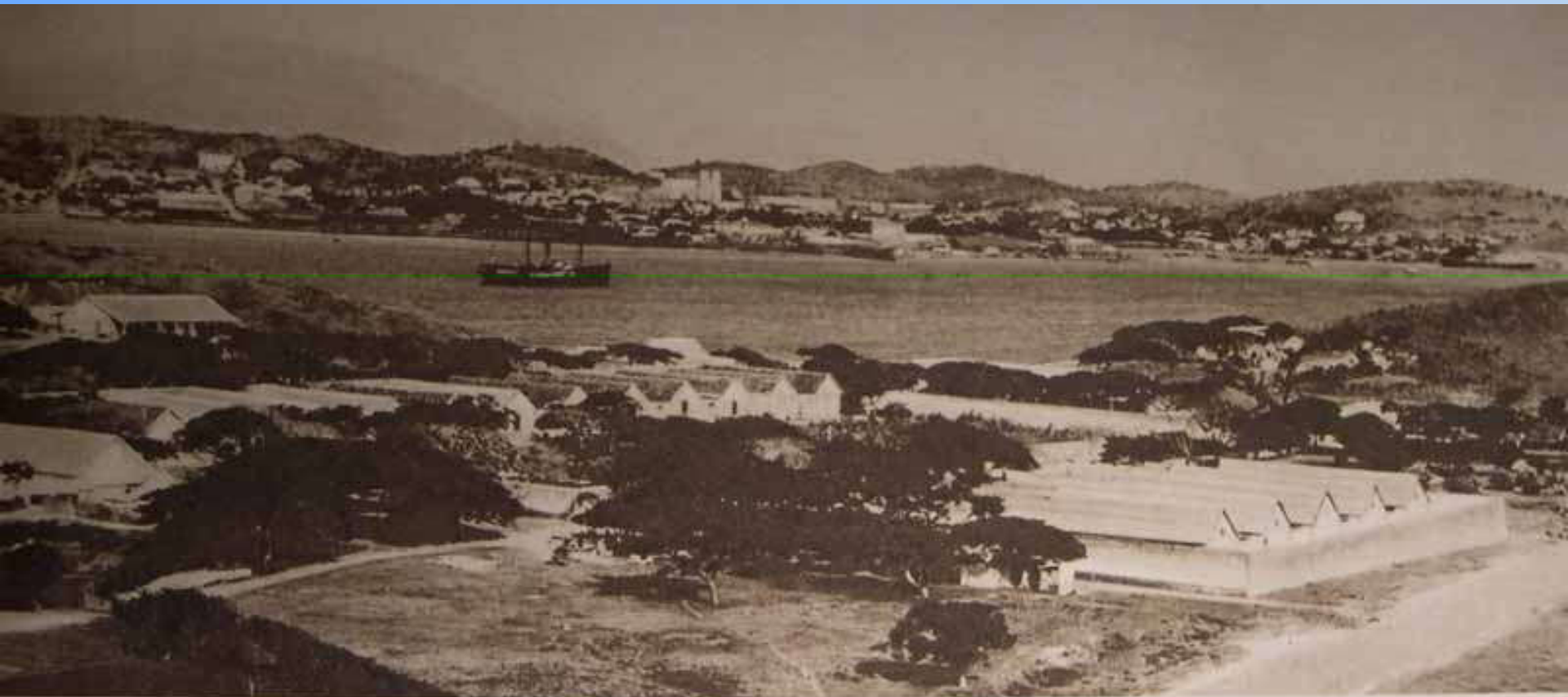
Vue générale du port et de la ville de Nouméa. — Au premier plan, le camp Est de l'île Nou.
